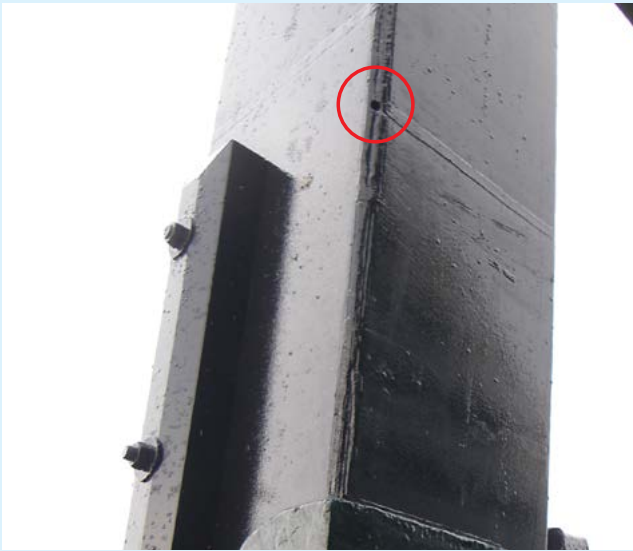
Ontwateringsgat in stuiklas.
