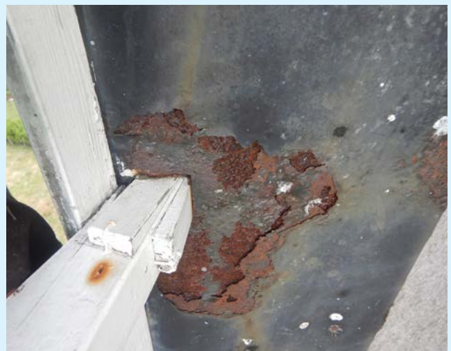
Roestvorming bij coating rondom heklatgat
