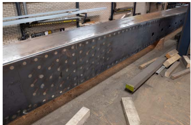
Nieuwe geklonken roeden in de werkplaats
