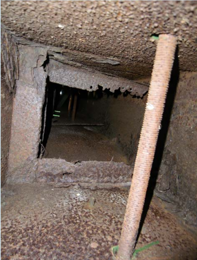
Inspectiefoto van binnenzijde roede ter hoogte van de wigschotten
