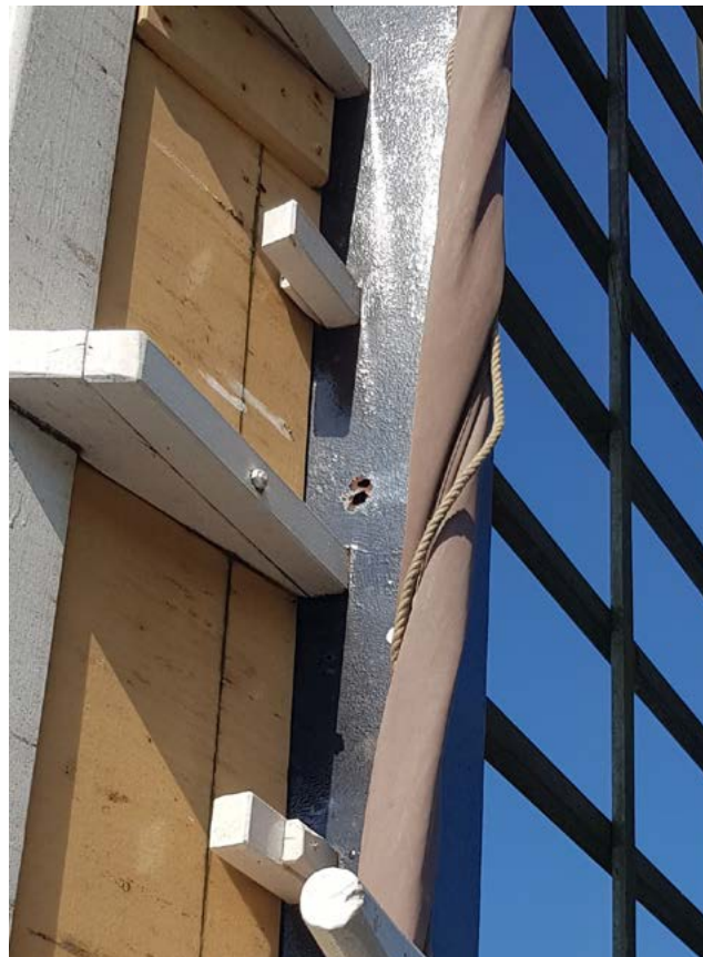
Doorgeroeste roede waarvan altijd hetzelfde end beneden stond.
