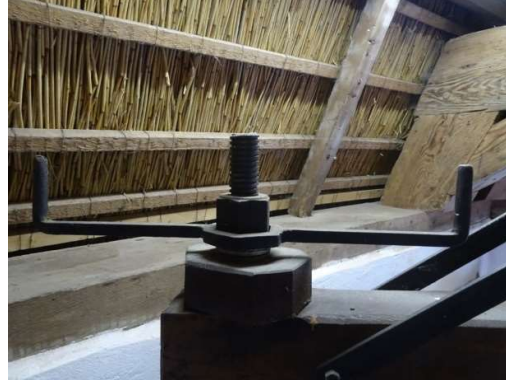
Borging op uiteinde spindel ontbreekt
