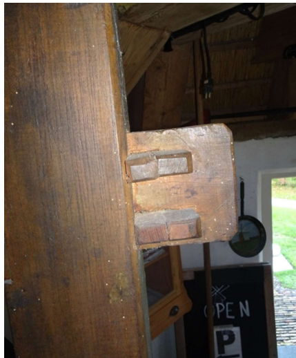
Bevestiging arm kraan vast, geen speling en geborgd
