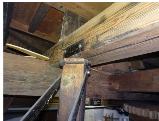
Taplaat zit met te kleine houtfretten vast
