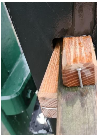
Foto bij 25a – Voorbeeld van een goed heklatgat in situ: het gat is glad afgewerkt en de hoeken zijn afgerond.
