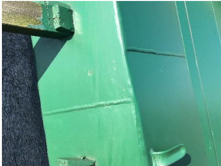
Foto bij 24 – De stuiklassen in de voor en zijplaat verspringen hier minimaal 100 mm, de las in de zijplaat zit mooi tussen de heklatgaten in.
