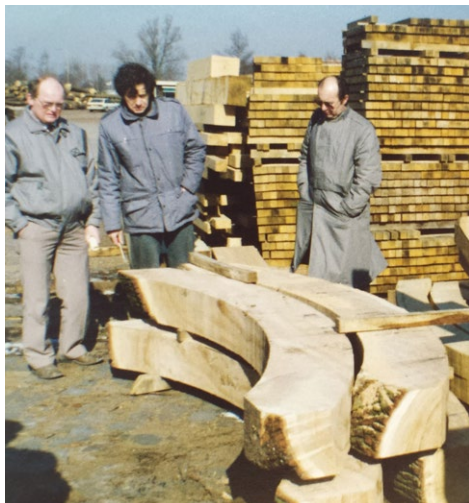
In 1986/1987 is Gerrit Keunen betrokken bij de restauratie van molen De Windotter in IJsselstein. Op de foto keurt hij (midden) het hout voor de nieuwe overringstukken van de kap. (Foto: Collectie Maarten Dolman)
