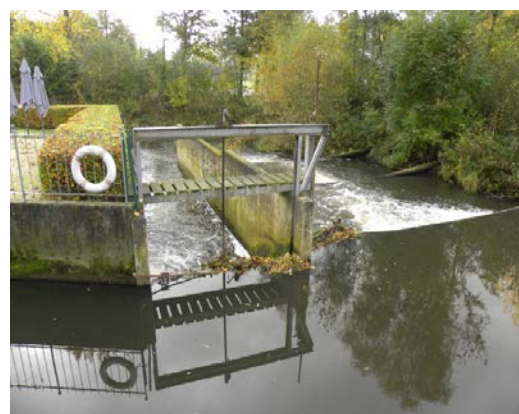
Lossluis (links) en visstrap/overlaat (rechts)
